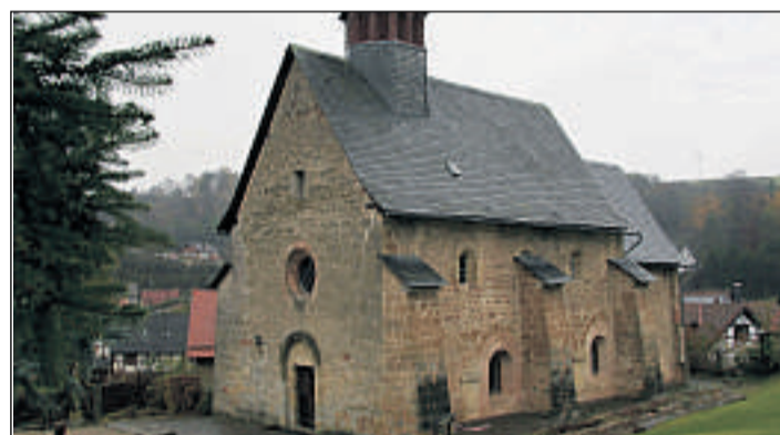
Einst dreischiffige Basilika mit flachem Dach: die Kirche in Ober-Werbe. Weitere Sanierungsabschnitte stehen an.
